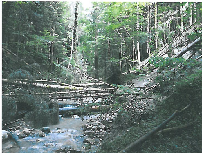
Total verlegte Grabenstrecke nach dem Hochwasser 2013
